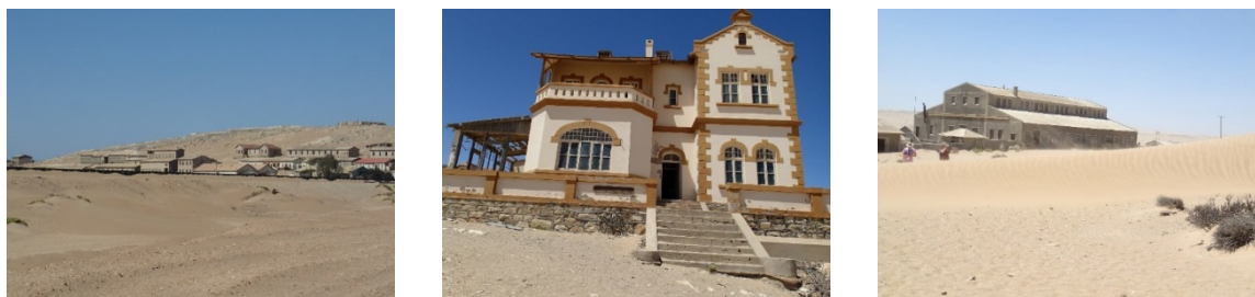
Ryc. 3. Kolmaskop. Ogólny widok (od strony wschodniej) na centralną część Kolmaskop. Budynek na zboczu wzniesienia w centralnej części zdjęcia to dom lekarza. Poniżej niego (budynek otynkowany na białło) – dawne sklepy, obecnie muzeum. Na wzgórzu – zbiornik na wodę, podłużne budynki w prawej części zdjęcia (na drugim planie) to domy z mieszkaniami dla pracowników z rodzinami. Budynek w lewej części zdjęcia – jeden z domów z mieszkaniami dla pracowników nieposiadających rodzin (zdjęcie lewe). Odnowiony i udostępniony turystom do zwiedzania dom dyrektora (zdjęcie środkowe). Obiekt, w którym przemycano wydobyte na pustyni diamenty (zdjęcie prawe). Stan z 2016 r.
