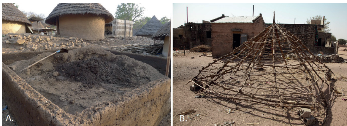
Ryc. 3. A. Ibel, wschodni Senegal. Widać przechodzenie z formy okrągłej na prostokątną z zachowaniem krytycznego wymiaru. B. Okolice Nioro du Rip, centralny Senegal. Więżba dachowa, widać małe przekroje elementów konstrukcji wykonanej z łatwo dostępnego materiału
