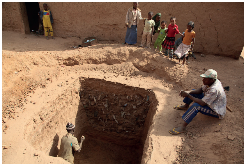
Ryc. 5. Budowa nowego domu na starym miejscu. Materiał z wykopu zostanie wykorzystany do wyrobu cegieł. W profilu wykopu widoczne współczesne nawarstwienia torebek plastikowych
