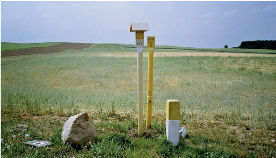
Fot. 1. Słupki znacznikowe instalowane nad gazociągami tranzytowym Rosja – Europa Zachodnia
