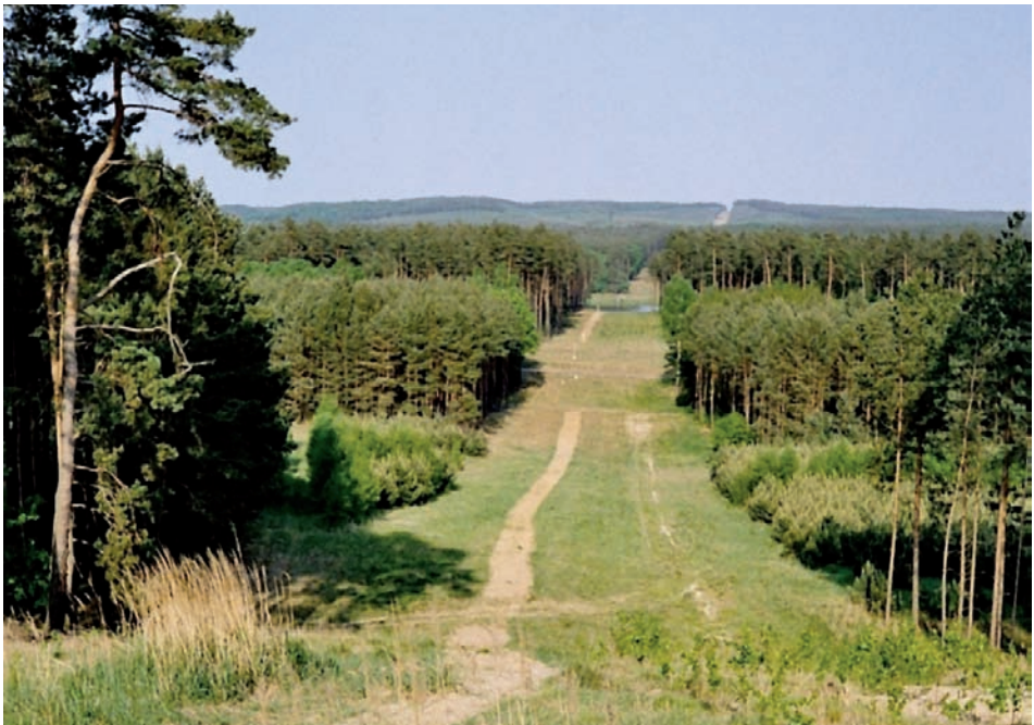
Fot. 2. Zmiany krajobrazowe na terenach zadrzewionych (na trasie gazociągu tranzytowego Rosja–Europa Zachodnia: województwo lubuskie okolice rzeki Lenki, około 5 lat po zakończeniu prac montażowych)
