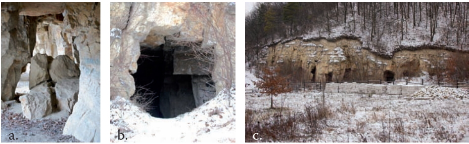
Rys. 2. a i b. Niestateczne korytarze poeksploatacyjne w Bochothnicy. c. próby „zabezpieczeń” przed niekontrolowaną turystyką (fot. R. Dziedziczak )
