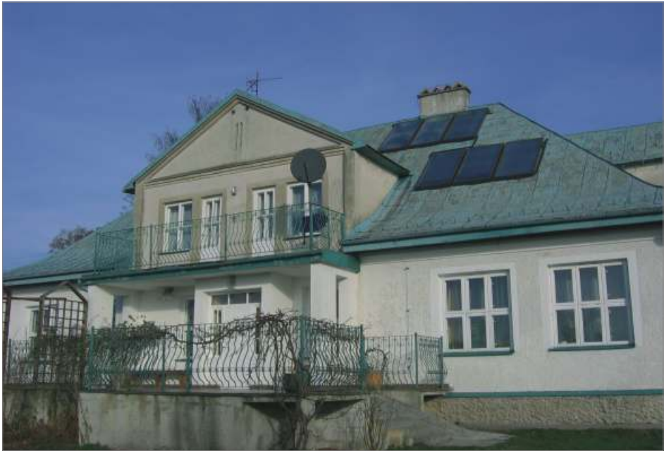
Fot. 8. Mazowieckie Obserwatorium Geograficzne w Murzynowie – fot. B. Kicińska
