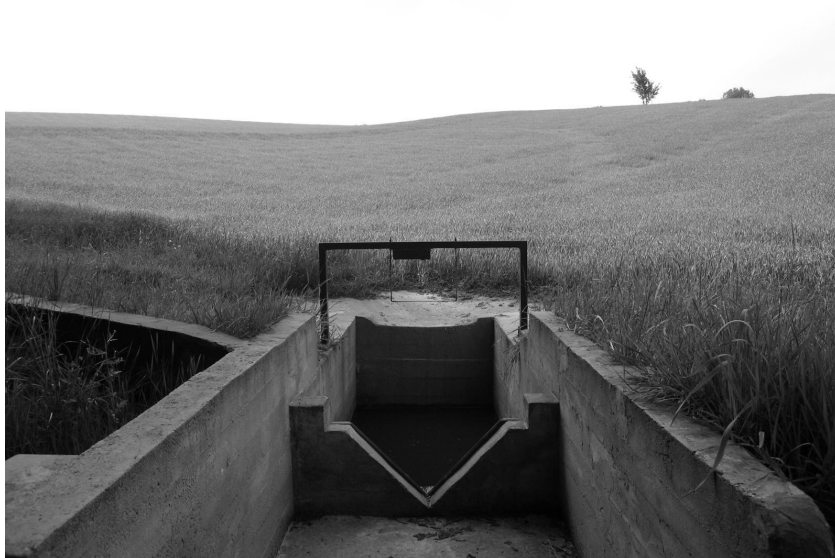
Fot. 1. Przepust przelewowy u wylotu mikrozewni - wg projektu E. Nowocienia Photo 1. The sluice-gate on the micro-watershed outlet - according to E. Nowocien project
